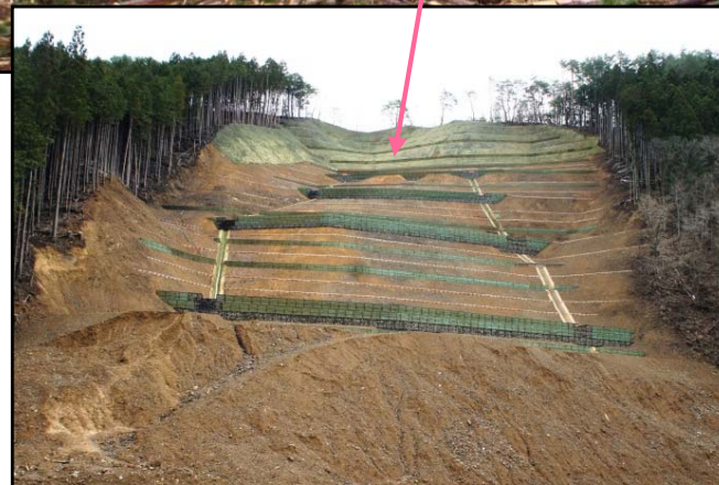
鋼製枠土留工、筋工、水路工 完成状況
