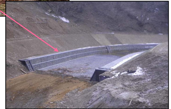
流路工 完成状況
