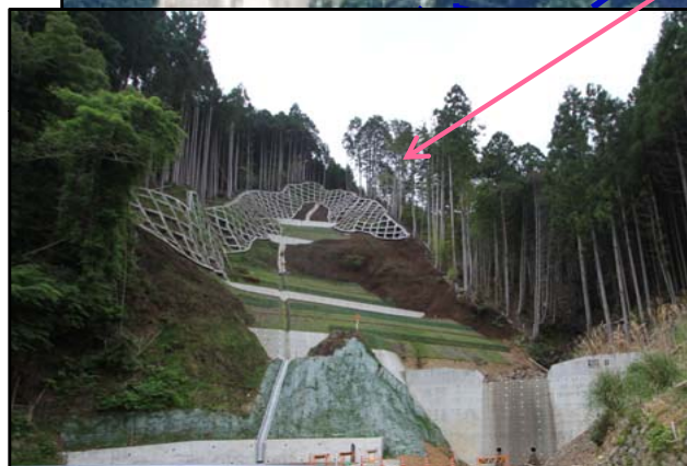
山腹工 完成状況
