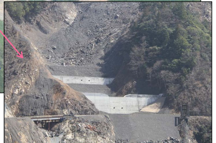
第1号谷止、第2号谷止 完成状況
