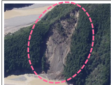
折立工区(被災直後) ・崩壊規模 2.36ha ・対策: 山腹工 (平成27年度工事完了)
