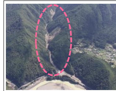
高津工区(被災直後) ・崩壊規模 2.67ha ・対策: 谷止工、山腹工 (平成30年度工事完了)
