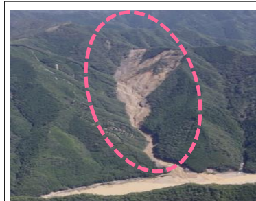
野尻工区(被災直後) ・崩壊規模 20.44ha ・対策: 谷止工、山腹工
