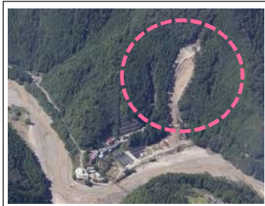
五百瀬工区(1号地)(被災直後) ・崩壊規模 0.47ha ・対策: 山腹工 (令和4年度工事完了) ※今年度調査のみ
