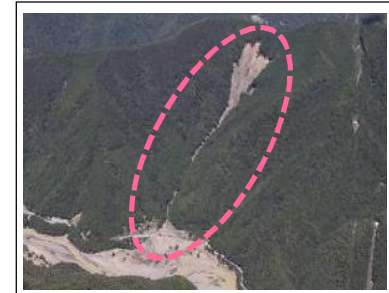
長殿(テラ谷)工区(被災直後) ・崩壊規模 2.75ha ・対策: 谷止工、山腹工
