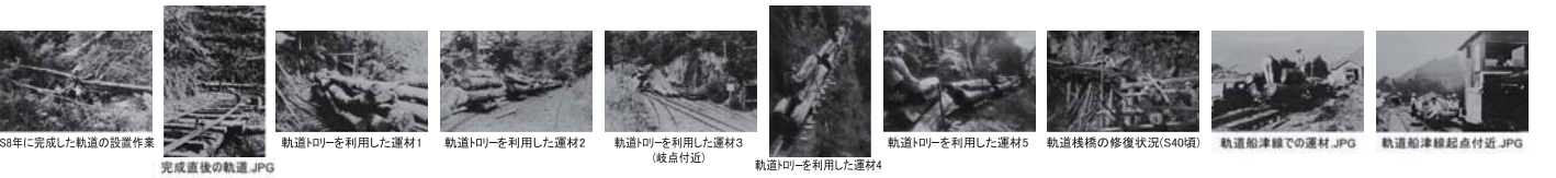
S8年に完成した軌道の設置作業
