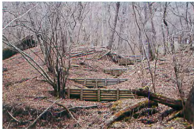
写真4 勾配の緩和による手法(丸太柵工)
