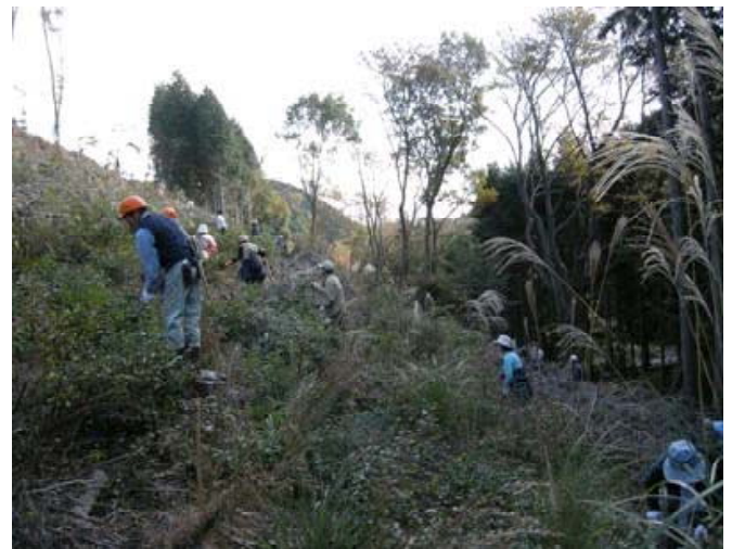
植樹作業の全景
