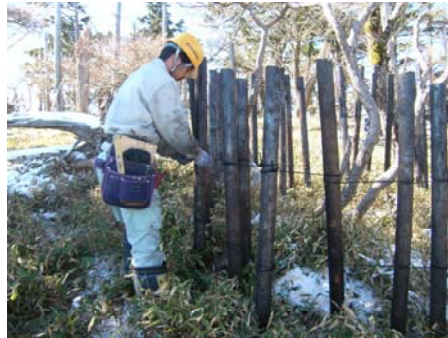
丸棒(地元の間伐材)を使った防鹿柵の設置 (円形で直径3メートル)
