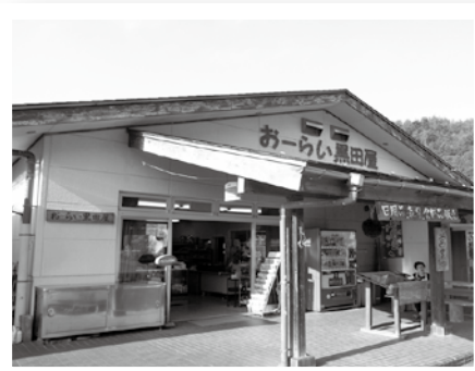
地域の共同店舗「おーらい黒田屋」駐車場を挟んで蔵があり、骨董品を販売。
