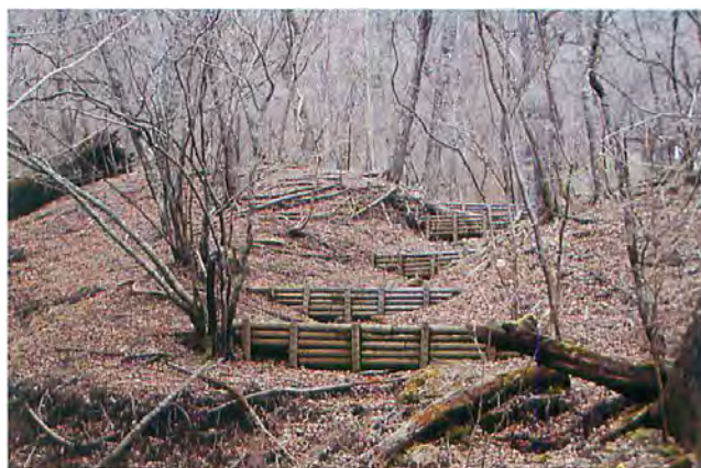
写真4 勾配の緩和による手法（丸太柵工）
