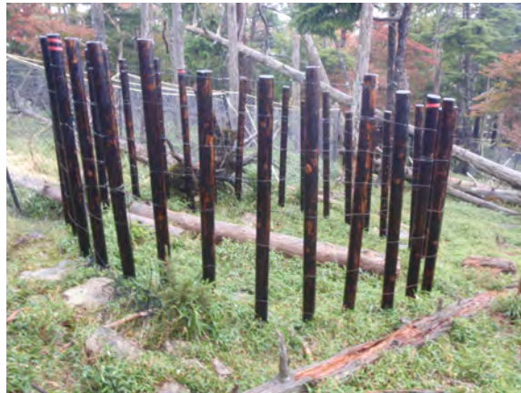
写真 1 杭を使用した植生保護柵
