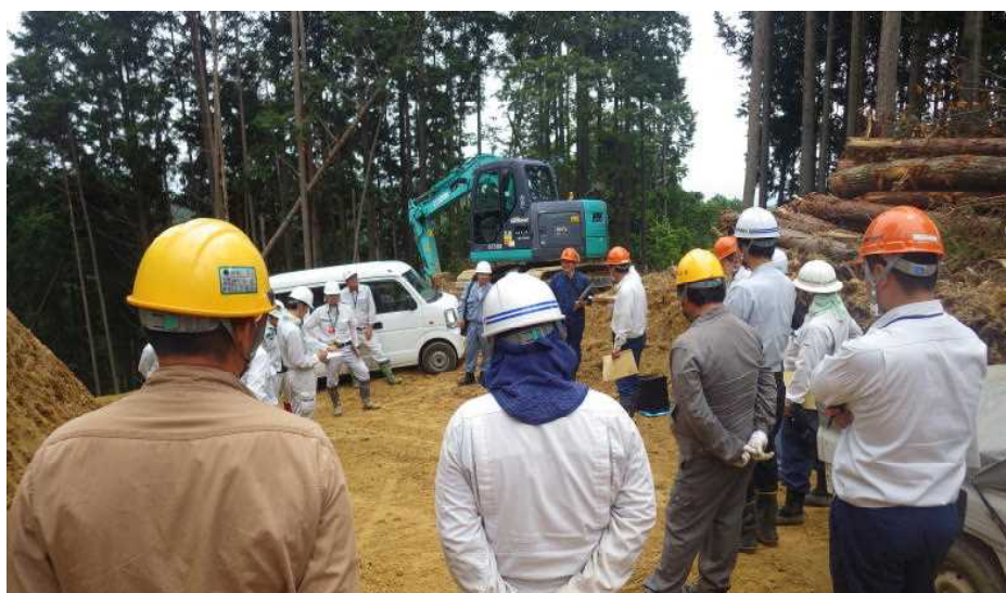
重機に関する安全指導の様子
