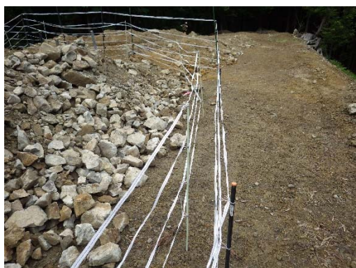
電気柵の二重設置
