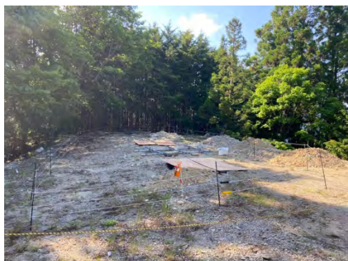
電気柵の設置
