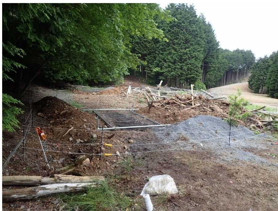
写真14 埋設穴①（いなべ市）に設置した埋設穴の掘削状況と柵等の設置状況
