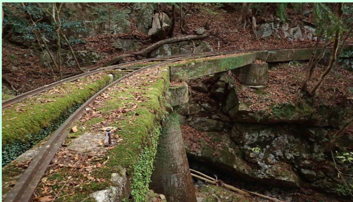
写真4 森林鉄道跡と苔むした橋
