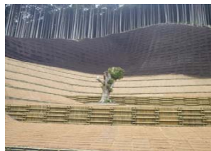
【山腹工に施工した丸太組土留工】
