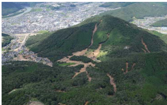
【高松山国有林の被災状況(遠景)】
