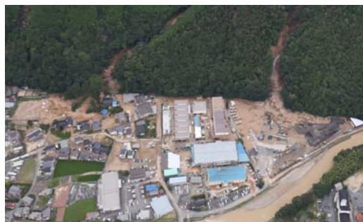
【高松山国有林の被災状況】
