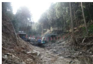
【強靱ワイヤーネット工施工状況】
