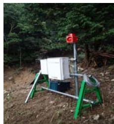
【土石流センサー設置状況】
