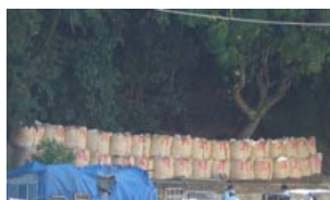
【大型土のうの設置状況】
