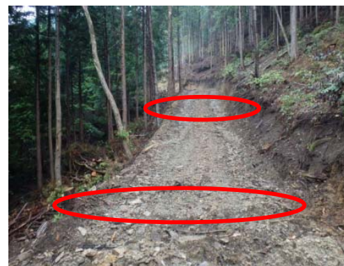
【森林作業道】 ～路面排水処理の状況～
