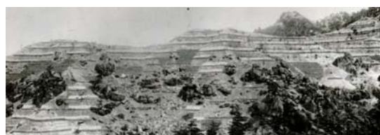
山腹工施工状況
