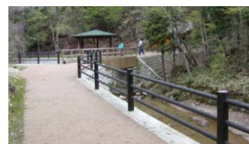
歩道整備状況
