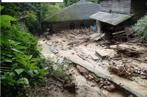
崩壊地内の様子
