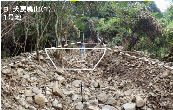
国有林内の崩壊状況
