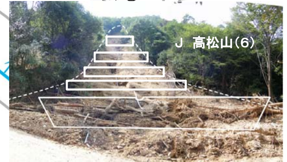
国有林内の崩壊状況
