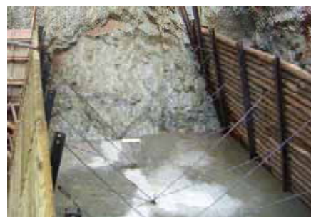
【コンクリート型枠に間伐材丸太を活用】
