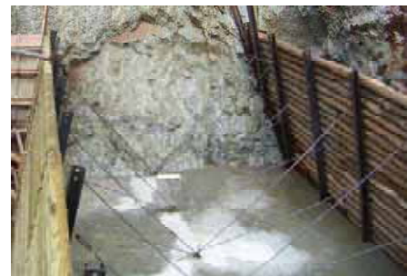
【コンクリート型枠に間伐材丸太を活用】
