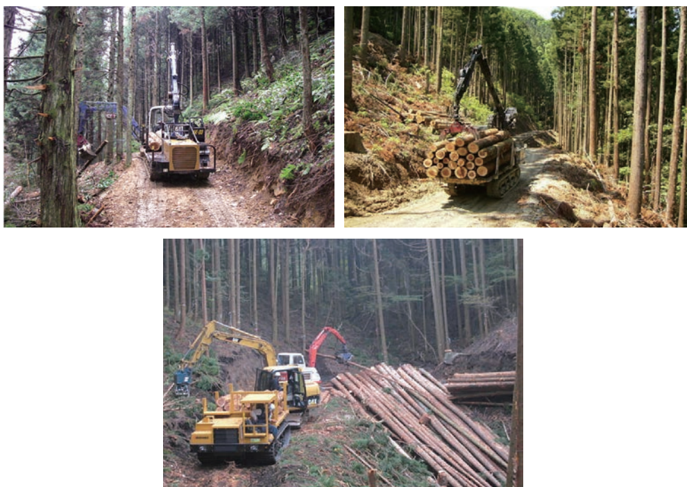
写真5-3 森林作業道(林業機械が走行する集材作業に用いられる)
