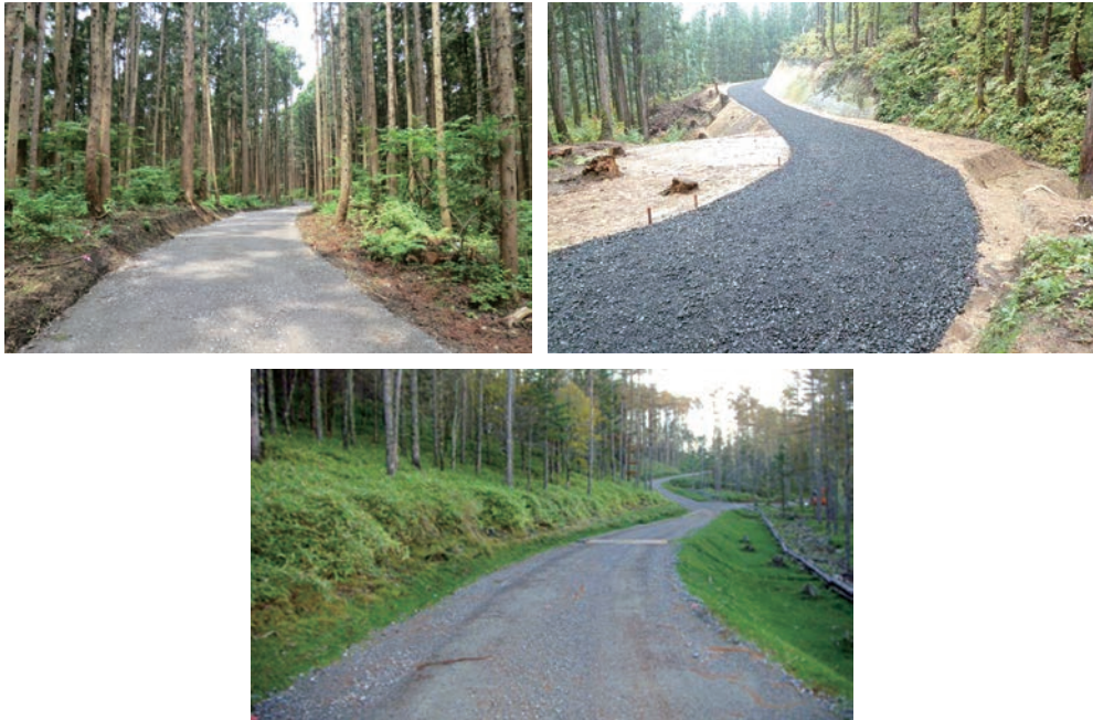
写真5-2 林業専用道(のり面は低く抑えられ、土工量が小さく、林内へのアクセスが容易)
