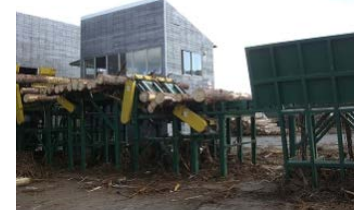
【システム販売先合板工場の様子】
