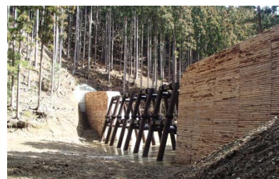
間伐材を使用した型枠
