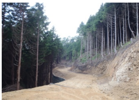
団地内林業専用道(国有林内)
