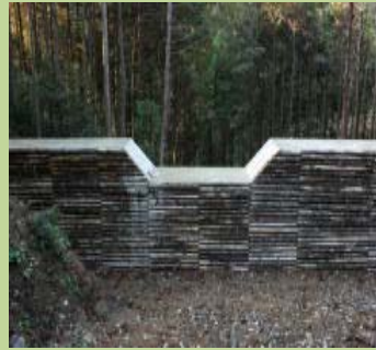
木製残存型枠を使用した 治山えん堤
