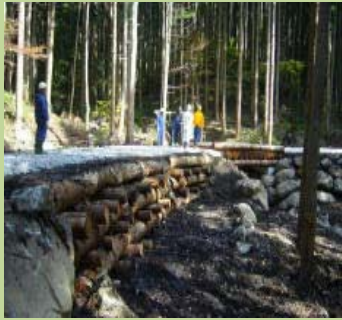
丸太組土留工・木橋
