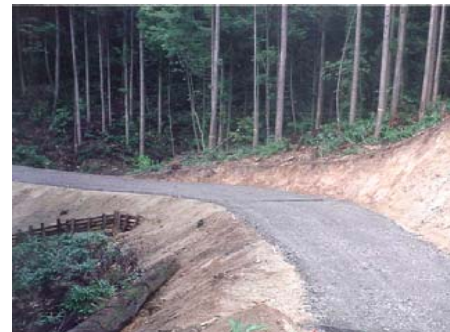
鈴ノ大谷（入江山）幹線作業道開設工事 （完成時写真）
