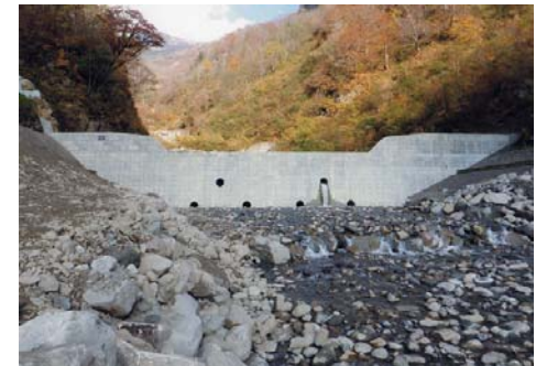
湯の谷第15-1号えん堤工事 （完成時写真）
