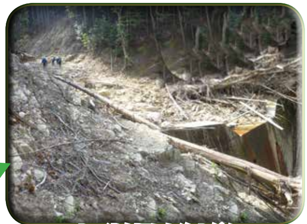
土石流を捉えた方治山ダム
