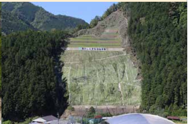
十津川村折立地区（施工後）
