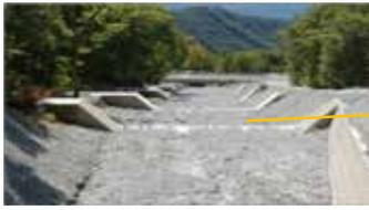
床固工群と護岸工により土砂を安全に流す対策を実施
