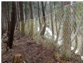
立木を活用した防護柵
