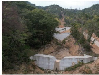
平成 30 年豪雨からの復 旧状況（広島県東広島）
