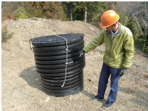
埋設処理のための大型排水管
