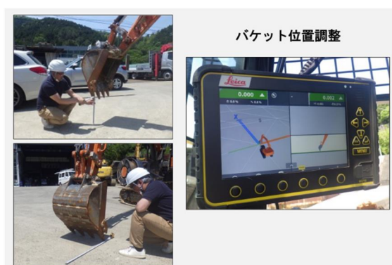
写真－4 MG 斜面掘削機のシステム概要②
