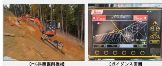
図-3 MG (マシンガイダンス) 斜面掘削工
