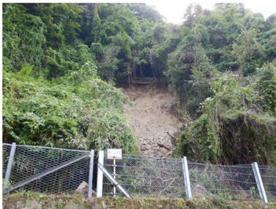
写真-2 工事施工前
