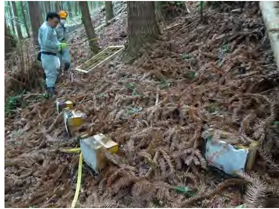
写真-2 土砂受け箱の設置
