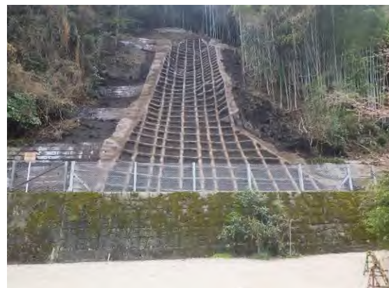
写真-3 工事完成後
