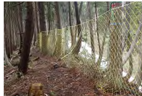
写真－７ 立木使用の設置写真
