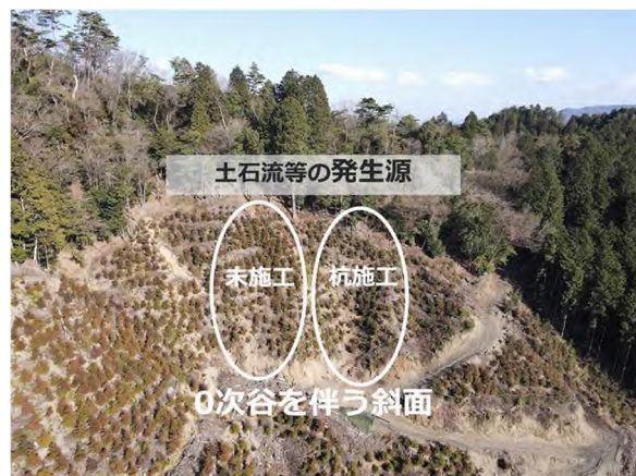
写真－4 試験施工地
