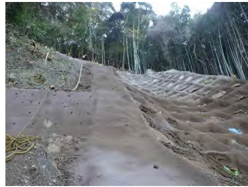
写真－7 モルタル吹付完了
