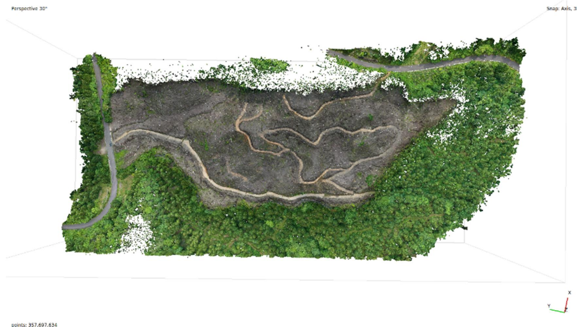
図-3 約1,200枚の空撮画像から構築された高密度点群モデル
