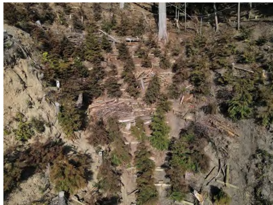
写真-5 施工後の様子
