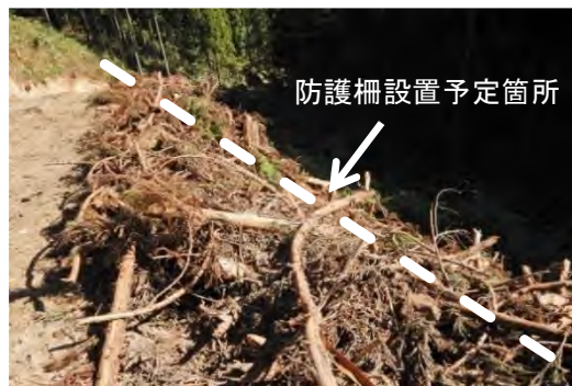
写真－3 防護柵設置時の支障
