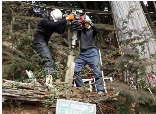
写真－2 木杭の打設
