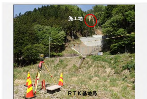
写真－5 RTK 基地局設置状況
