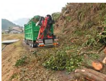
写真－5 グラップルによる積込み
