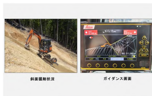
写真－6 MG 斜面掘削機の掘削作業状況
