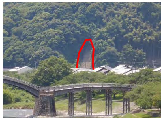
写真-1 城山国有林工事箇所
