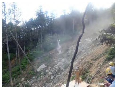
写真－４ ラジコンヘリ施工状況
