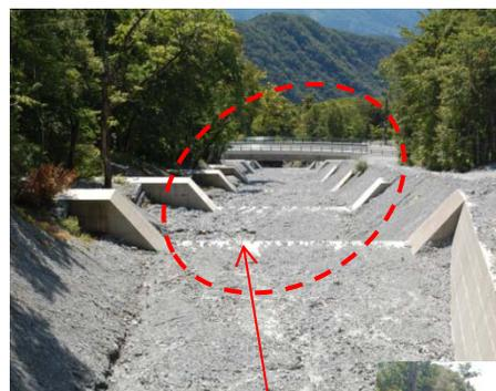
・下流側に安全に土砂を流すために、川床を固定
