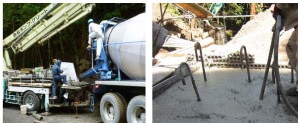
現地発生土砂・セメント・水を攪拌、混合
