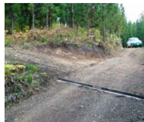
木製路面排水工による横断排水の事例
