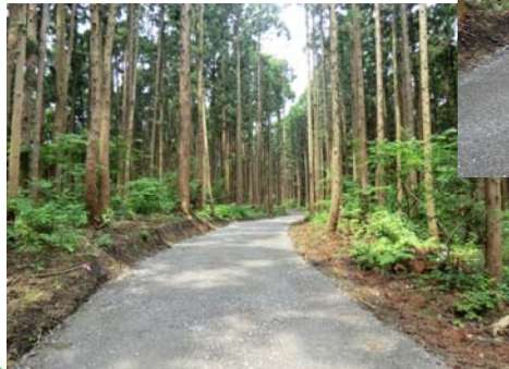
森林作業道の取付が容易な低い法面
