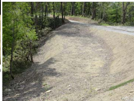
森林作業道の取付けを意識した盛土工
