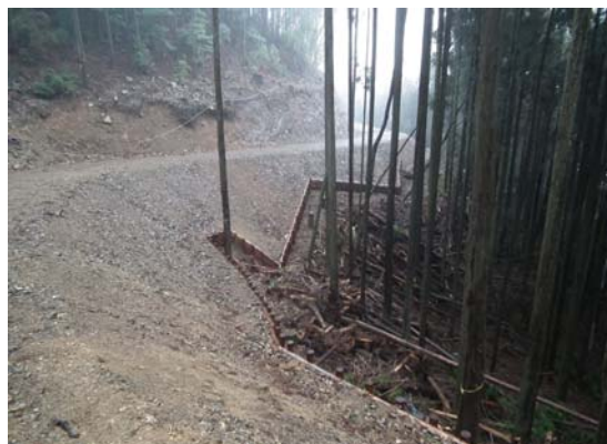
木柵工の施工事例（施工後の写真）
