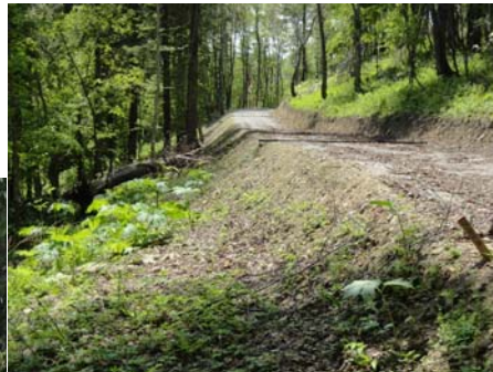
1:1.2の盛土でも安定し緑化が始まっている
