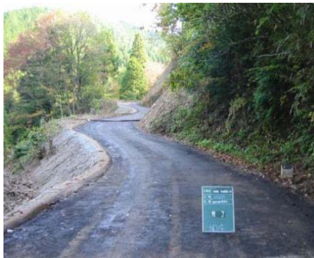
鉄鋼スラグを利用した路面工
