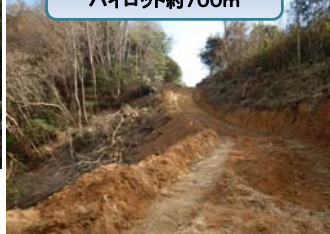
作業道作設中 パイロット約700m
