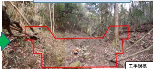
鋼製枠谷止工1基(写真は計画箇所)
