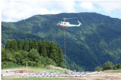
袋型土留の施工状況（資材の吊り下げ状況）
