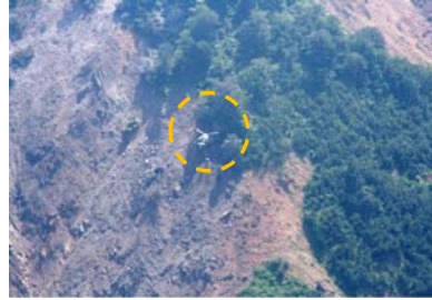
侵食防止剤の吹付状況（1回の吹付で1.4m四方を吹付）
