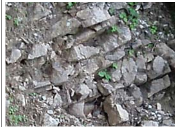
崩壊地周辺の脆い地質 (崩壊が発生している大汝園有林内の基岩)
