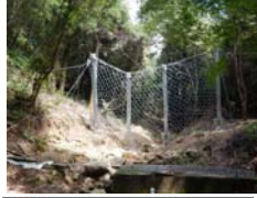
強靱ワイヤーネット設置状況
