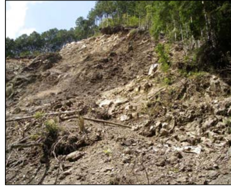
破砕された脆弱な地質の状況 (神納川地区五百瀬2) (平成24年6月撮影)
