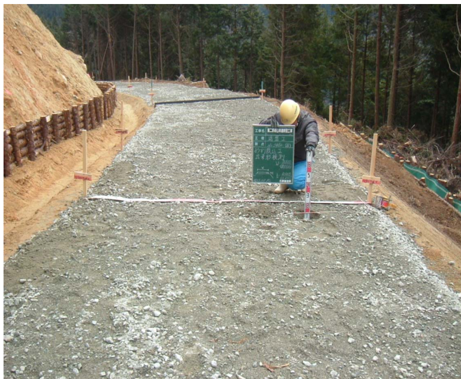
砂利敷込出来形
