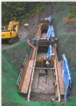
③(左岸袖)型枠組立て検測 撮影日:H.23.8.23
