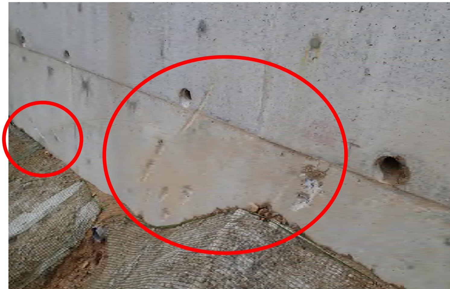
重機によるコンクリート構造物の破損
