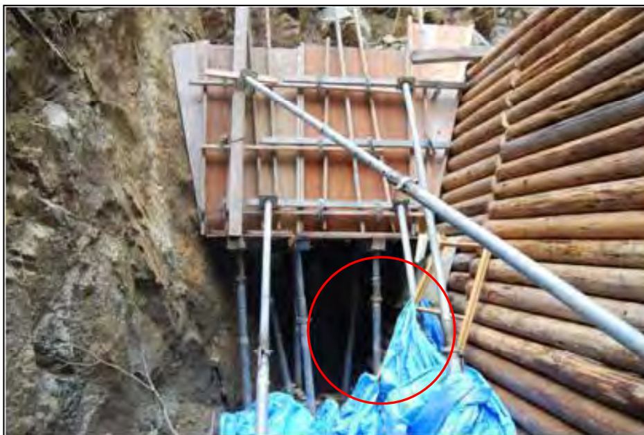
間詰が地山に密着していない
