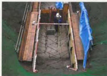
③(左岸袖)型枠組立て検測 撮影日:H.23.8.23
