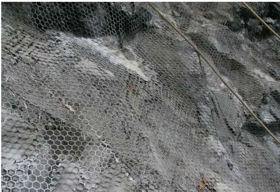
アンカーピン不足のため網が浮いている。
