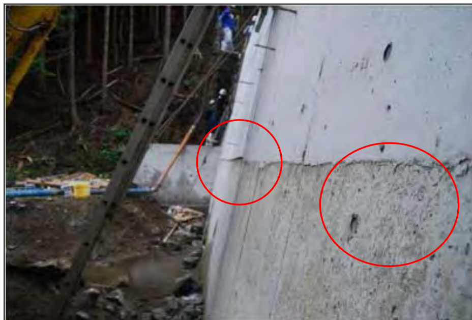
打継目の施工不十分
