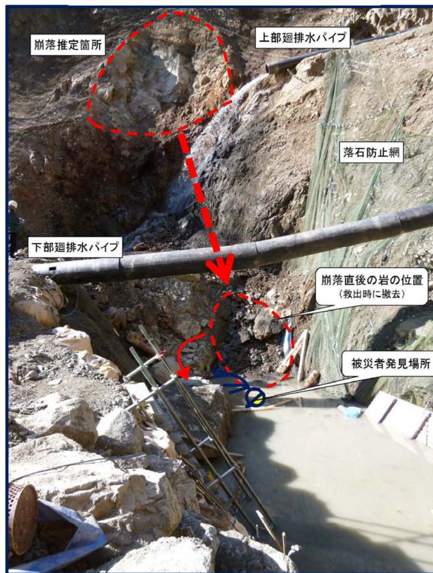
災害発生箇所現況写真(発生後) (長野県伊那市黒河内国有林234い林小班)
