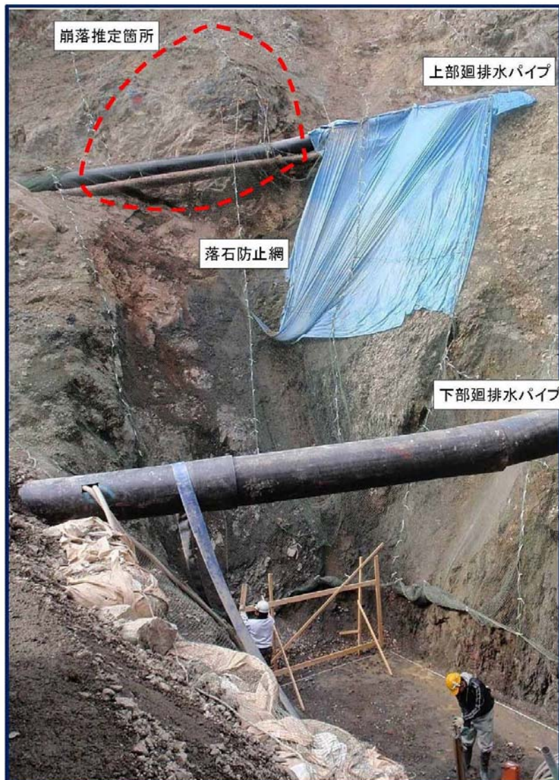
災害発生箇所現況写真(発生前) (長野県伊那市黒河内国有林234い林小班)
