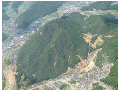
【高松山国有林の被災状況(遠景)】
