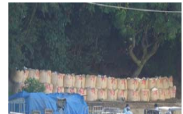
【大型土のうの設置状況】
