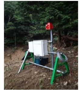
【土石流センサー設置状況】
