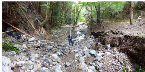
【平成25年台風18号災害による溪流荒廃の状況】 (滋賀県大津市 関寺国有林)
