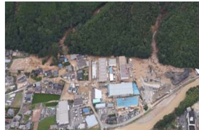
【高松山国有林の被災状況(近景)】
