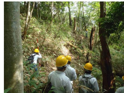
【現地での縦断勾配確認の様子】
