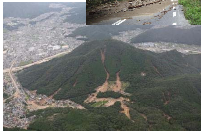
【犬戻鳴山国有林（右上）及び高松山国有林の被害状況】
