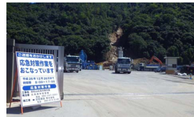
【流出土砂の撤去・運搬状況】
