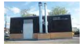
木質バイオマス熱利用施設
