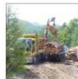
運搬 グラップル付 大型トラック
