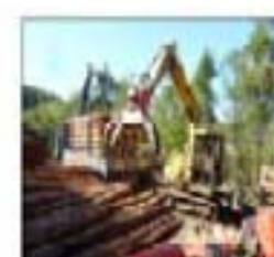
運搬 グラップル付 大型トラック
