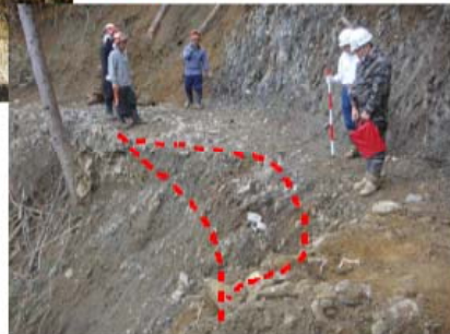
ずり落ちた森林作業道箇所 (先山側から見た写真) ↑ずり落ちたと思われる箇所 ↓
