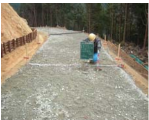
砂利敷込出来形
