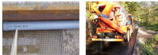
散水設備を設置することにより、ダンプ等の土を落とし、一般道が汚れるのを防止している。
