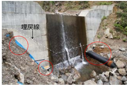
廻排水用パイプ・型枠・ブルーシート等を埋戻し時に埋設している
