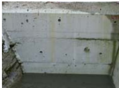
あばた、豆板、水平打継目の不良
