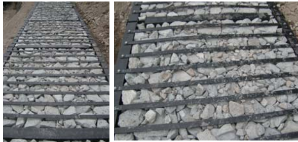
設計図書等の規格以外の詰石を使用している(詰石が小さい)
