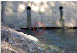
不適切な暗渠 埋戻部分が流水により破壊され洗掘の誘因となる
