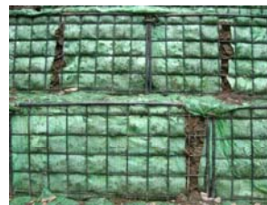
緑化シートが引っ張られて破損、編み目より詰石が小さい、カゴ枠天端の処理
