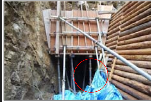
間詰が地山に密着していない
