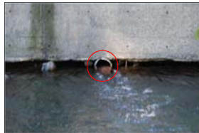
不適切な暗渠 埋戻部分が流水により破壊され洗掘の誘因となる
