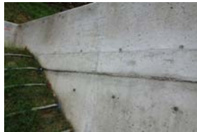
あばた、豆板、水平打継目の不良
