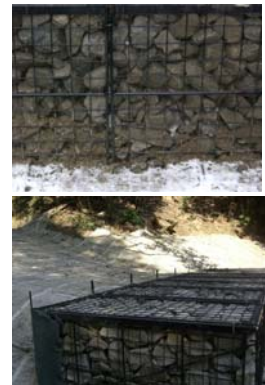
緑化シートが引っ張られて破損、編み目より詰石が小さい、カゴ枠天端の処理
