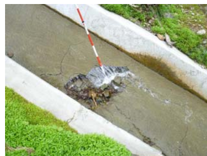
底張コンクリートの厚み不足
