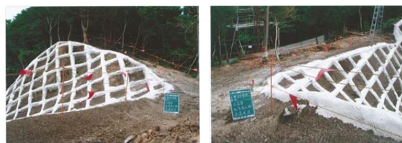
ロープ等により転落防止等を防ぐため対策がされている
