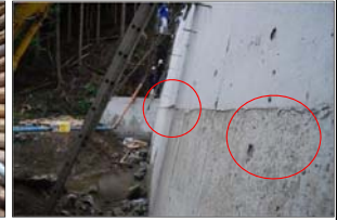
打継目の不良
