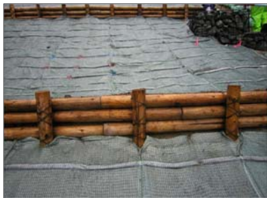
標準図どおり横木を千鳥に配置して施工している。
