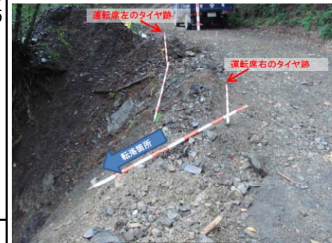
ホイールローダ転落箇所
