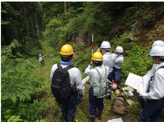
既設森林作業道の縦断勾配を確認
