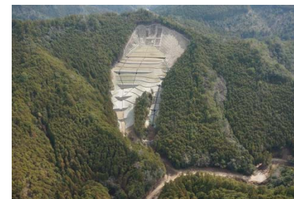
（八升前区域の施工状況）
