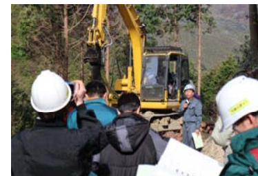
【請負者による作業工程の説明】
