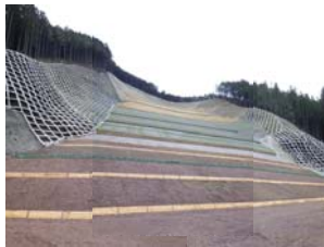
【天川村川坪内区の復旧の様子】
