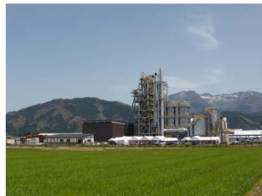
(木質バイオマス発電所)
