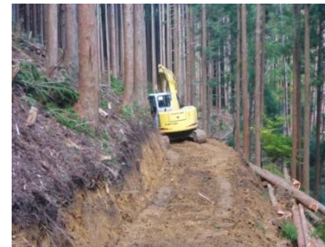
(桧股国有林内に作設中の森林作業道)
