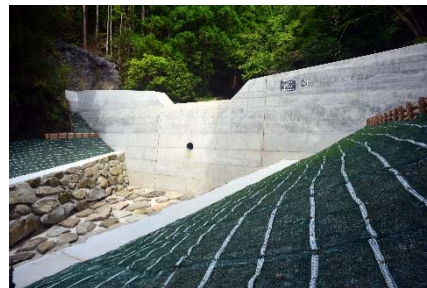
（国有林で施工した溪間工事）
