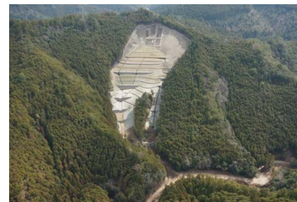
（八升前区域の施工状況）
