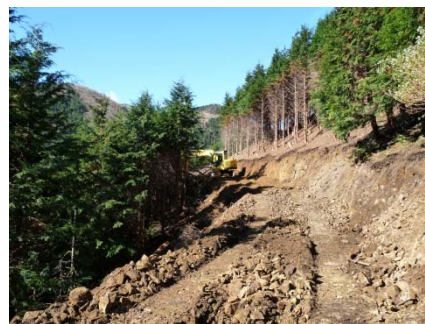
（作業道作設の様子）
