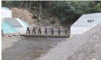
（H28施工したスリットダム）
