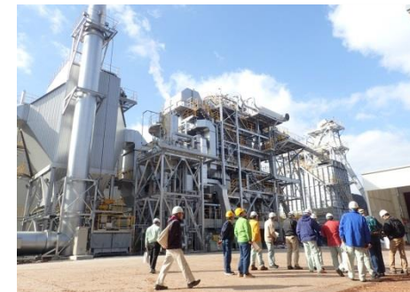
【兵庫県職員との合同現研修会の様子】 （朝来市バイオマス発電所見学）
