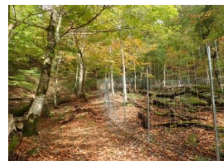
【音水国有林シカ防護柵設置の様子】
